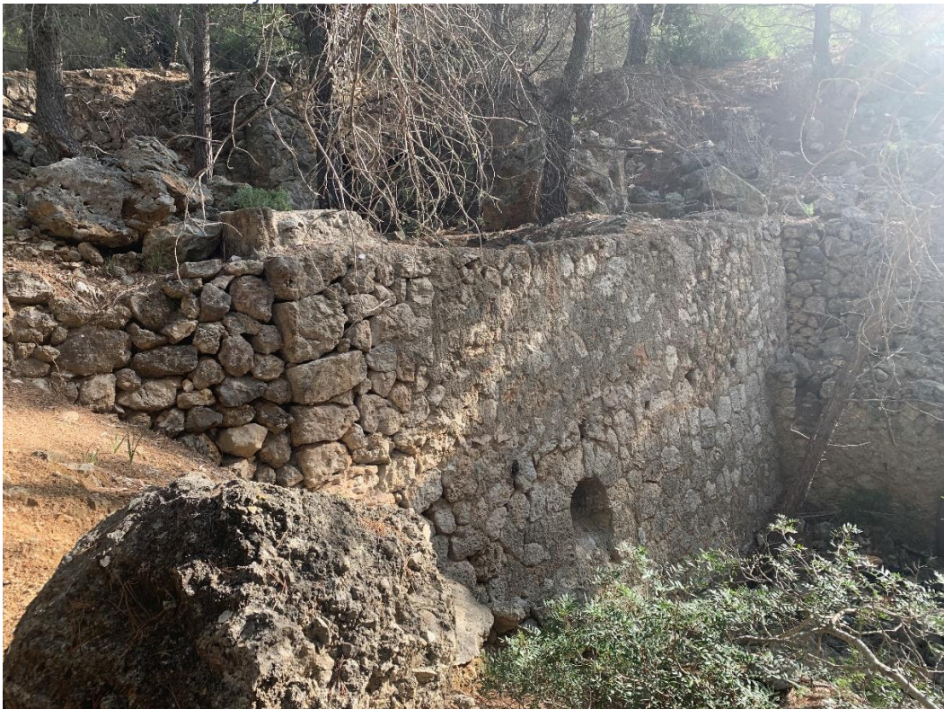
Forn de guix de les coves del Pilar
